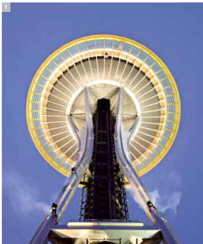
1 Nejvyšší stavba v Seattlu – Space Needle Tým firmy Kärcher čistil vysokým tlakem ve výšce až 184 m. 8 týdnů – a pouze v noci.
